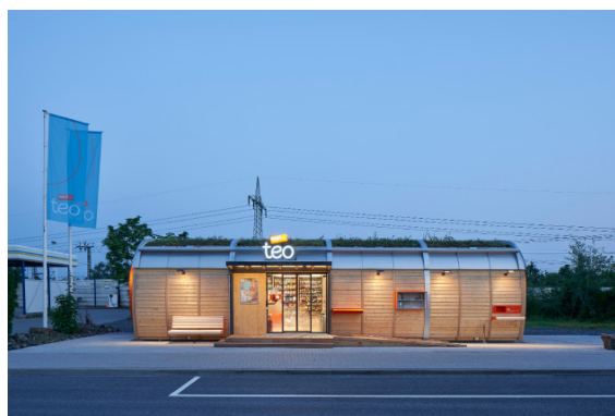
04: Das innovative Konzept von „tegut... teo“ drückt sich auch in der ganzheitlich gestalteten Außen- und Innenbeleuchtung aus.
